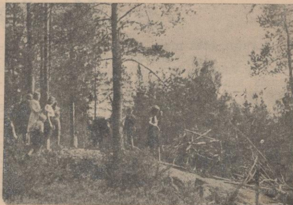
Kokkoa rakennetaan Kohtavaaralla.
