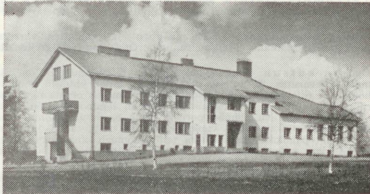
Opiston päärakennus edestä Kannessa päärakennus rannan puoleita kuvattuna
